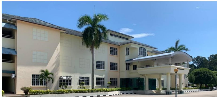
PANDANGAN HADAPAN BANGUNAN
