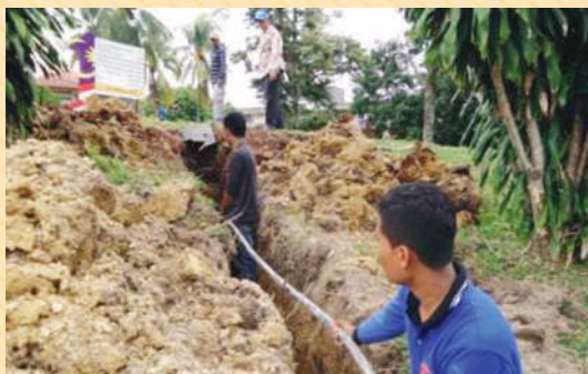
KERJA-KERJA MENANAM KABEL BAWAH TANAH DI WISMA BINTARA 2 BRIGED
