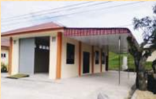
KERJA-KERJA MENAIKTARAF BANGUNAN STOR PELARASAN
