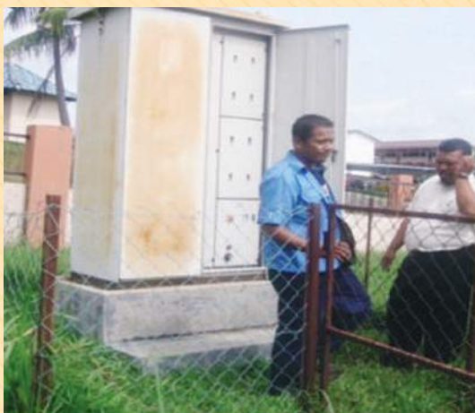
PEMERIKSAAN FEEDER PILLAR ELEKTRIK OLEH STAF JKR TENTERA
